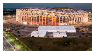
INSTALLATION CHAPITEUX/MOBILIER /SANITAIRES COUPE D'AFRIQUE DES NATIONS 2023
